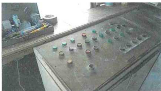
Fot. 5-węzeł betoniarski ZREMB B303
