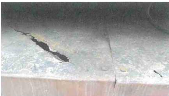
Fot. 95 - żuraw GROVE nr rej. PZ3203T
