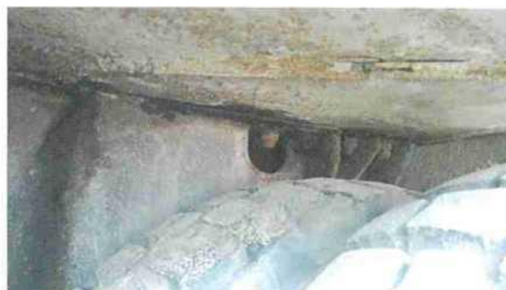
Fot. 94 – żuraw GROVE nr rej. PZ3203T
