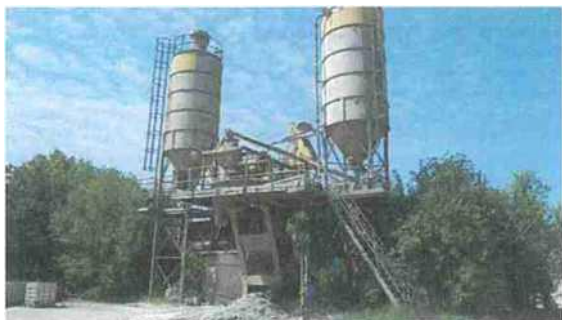
Fot. 1-węzeł betoniarski ZREMB B303
