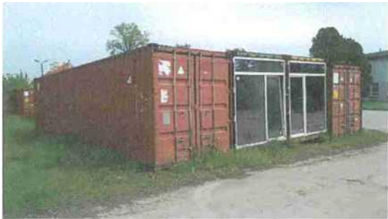
Fot. 155 - kontenery morskie
