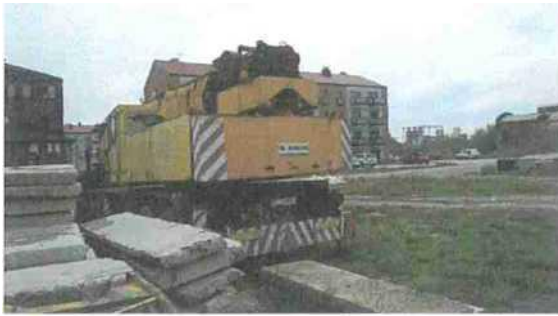
Fot. 73 - żuraw GROVE nr rej. PZ2398Y
