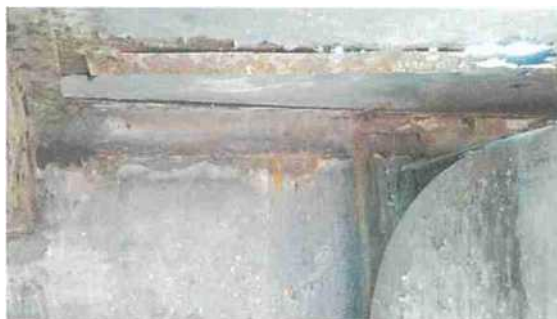
Fot. 96 - żuraw GROVE nr rej. PZ3203T
