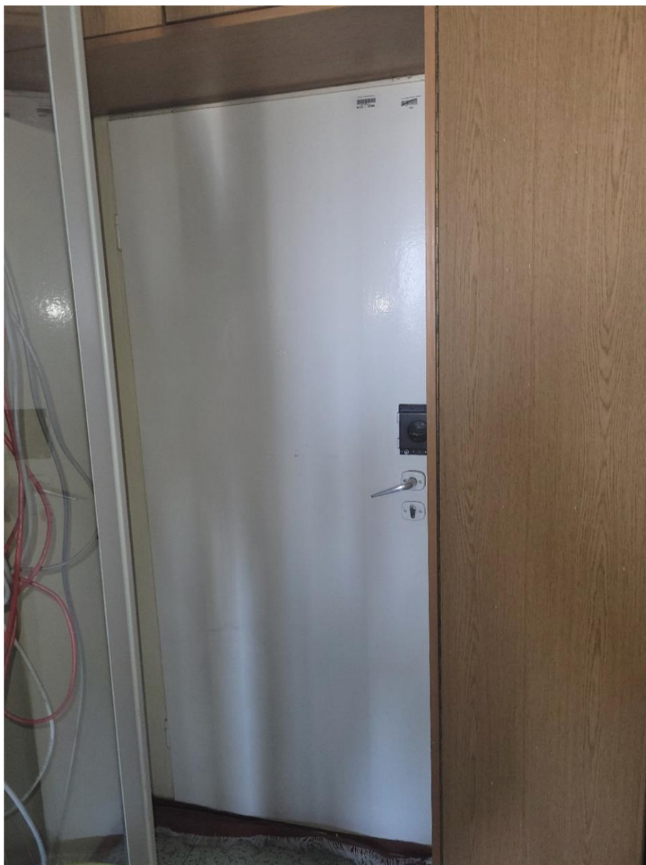
Rys. 3 drzwi do zamurowania, widok od strony serwerowni
